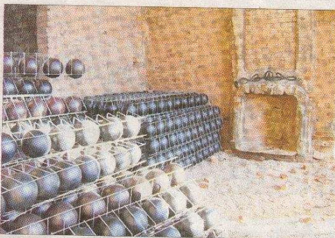
Im früheren zweiten fürstlichen Vorzimmer lagern die Kugeln, die in die neue Schlossdecke eingearbeitet werden.
