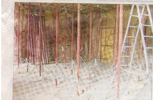
Ein Stützfeilerwald bestimmt derzeit das Bild in der großen Eingangshalle des Schlosses.
