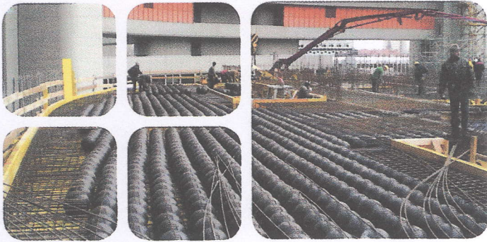
In den Decken wurde teilweise mit innovativen Kunststoffkugeln gearbeitet.
