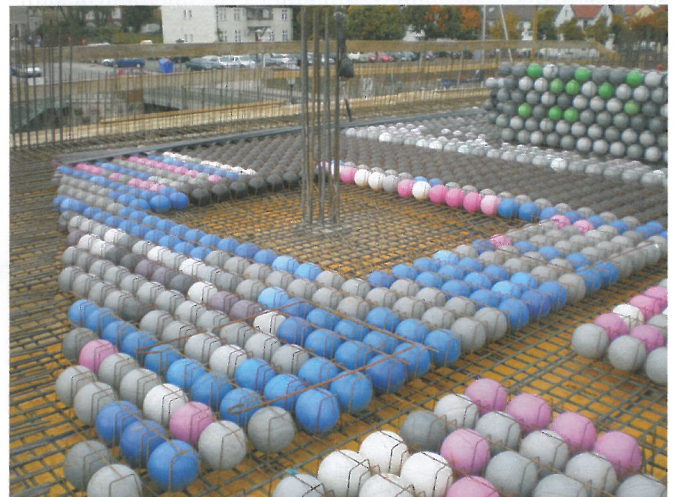
cobiax-Hohlkörpermodule auf der Baustelle
