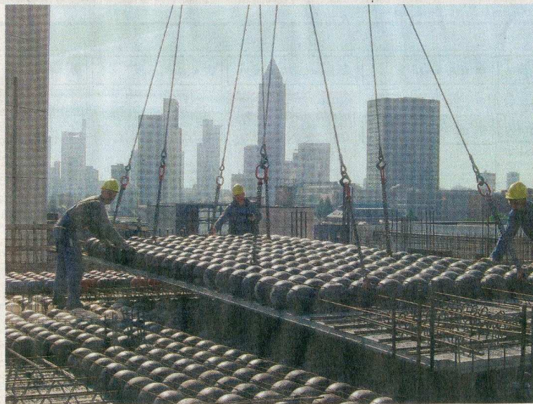
Wenn die kugelförmigen Verdrängungskörper bereits in der (Halb-) Fertigteilfabrik mit dem Unterbau der Flachdecken verbunden werden (oben), kommen sie fixiert auf die Baustelle. Im nächsten Arbeitsschritt kann aufbetoniert werden, ohne daß die Hohlkörper aufschwimmen. Für die Zollverein School of Management and Design in Essen (links) hat man unter die Kugeln Kunststoffrohre zur Bauteilaktivierung (Temperierung des Baus) gelegt.
