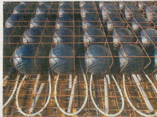
Wenn die kugelförmigen Verdrängungskörper bereits in der (Halb-) Fertigteilfabrik mit dem Unterbau der Flachdecken verbunden werden (oben), kommen sie fixiert auf die Baustelle. Im nächsten Arbeitsschritt kann aufbetoniert werden, ohne daß die Hohlkörper aufschwimmen. Für die Zollverein School of Management and Design in Essen (links) hat man unter die Kugeln Kunststoffrohre zur Bauteilaktivierung (Temperierung des Baus) gelegt.
