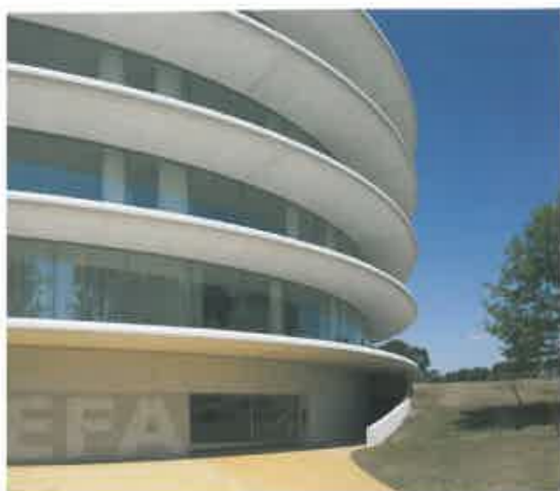
aus Betonfertigteilen leisten den Sonnenschutz
