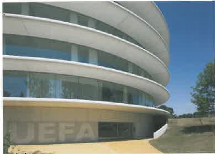
Die Vordächer aus Betonfertigteilen leisten den Sonnenschutz
