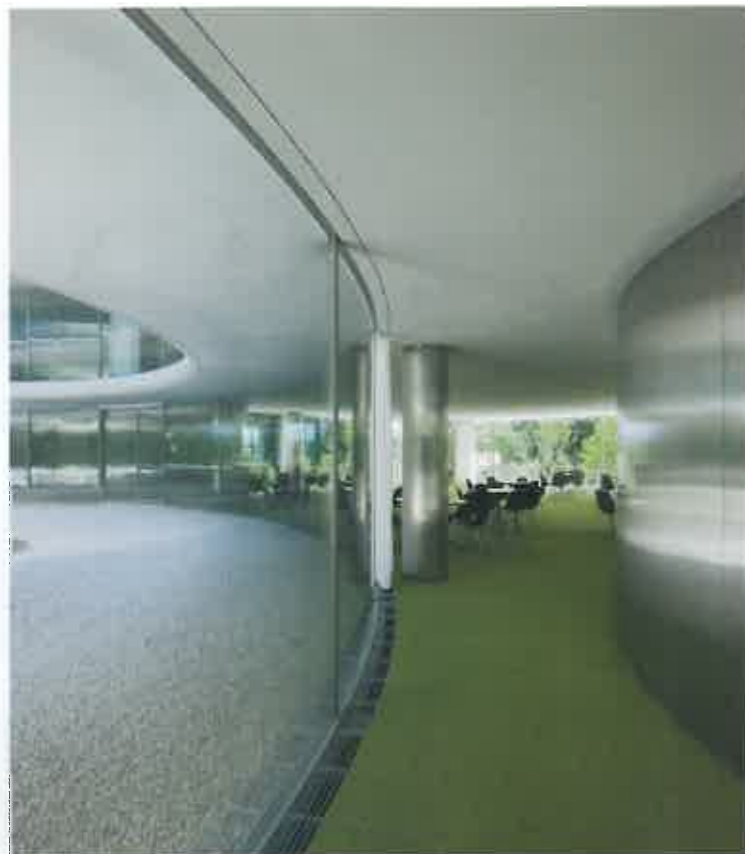
Die Fassade besteht aus 2,70 m hohen und 2,45 m breiten, gewölbten Glaselementen
