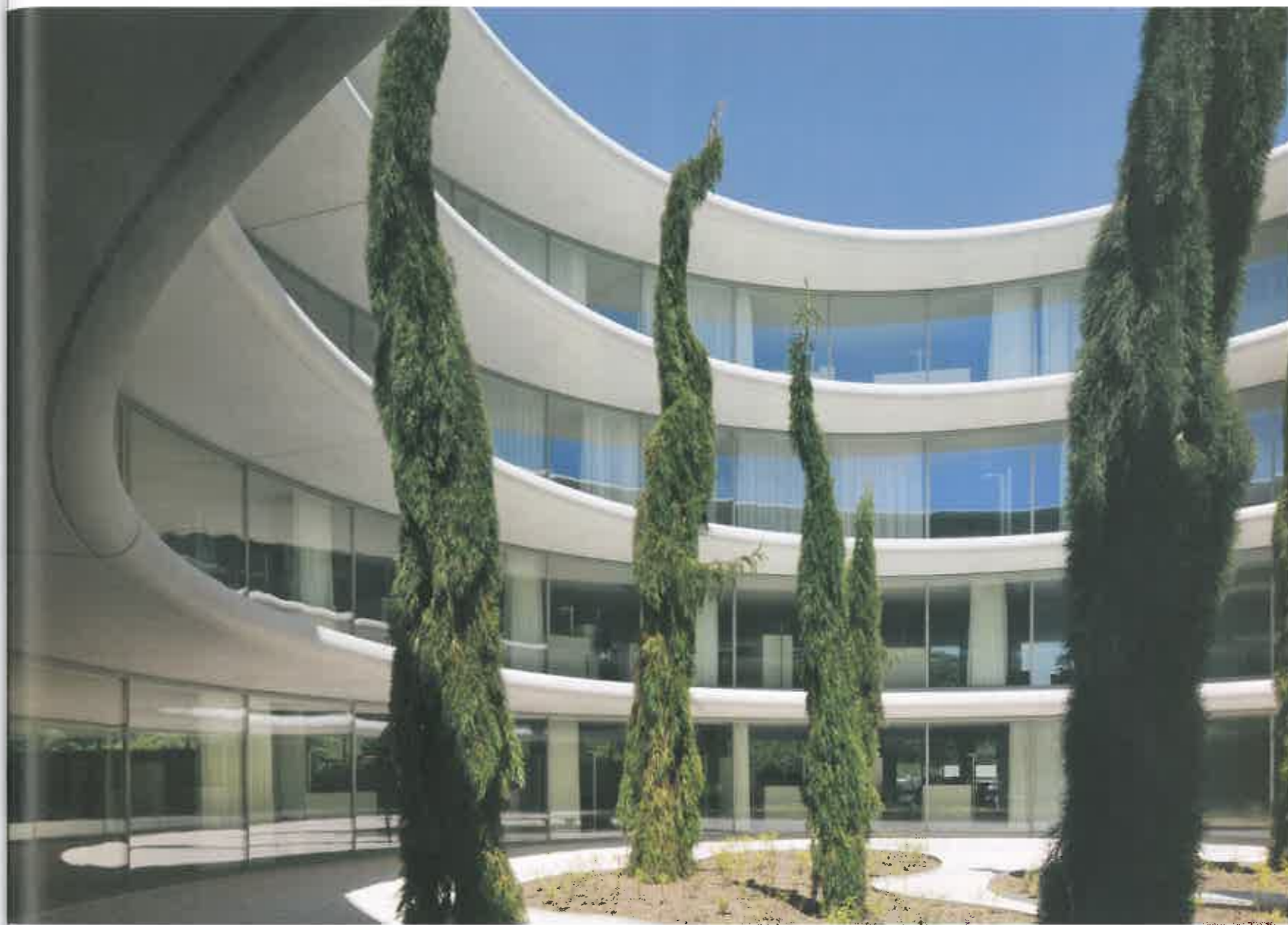
Solarkollektoren auf dem Dach dienen der Warmwasserversorgung
