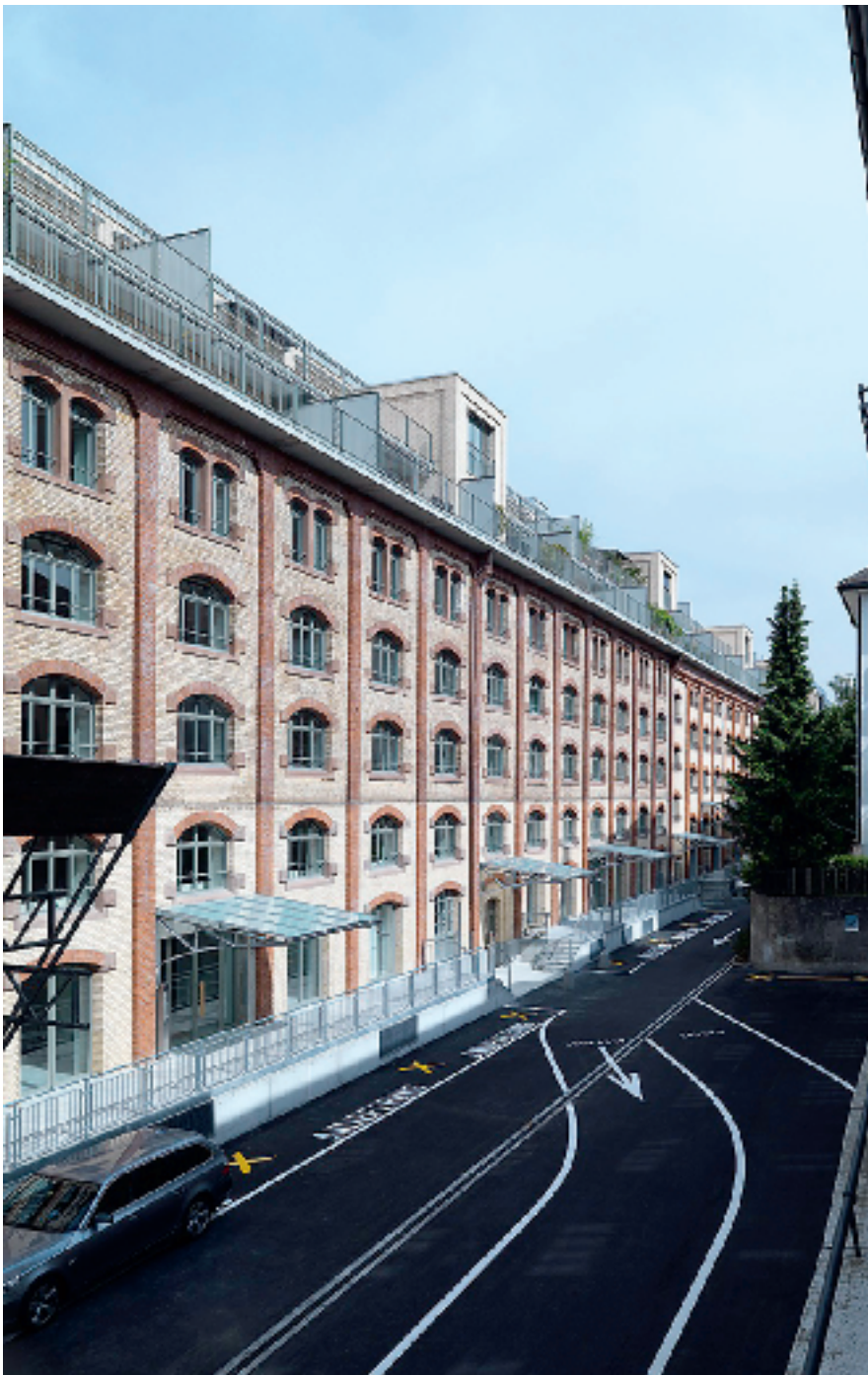
Blick auf die denkmalgeschützte Klinkerfassade und die zweigeschossige Aufstockung.
