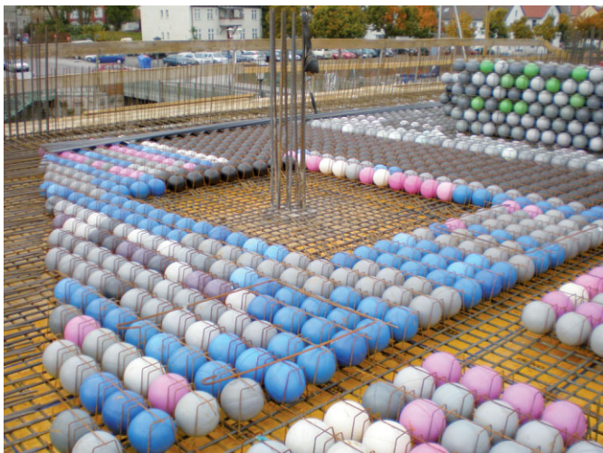
Bild 3. cobix ® -Hohlkörpermodule auf der Baustelle
