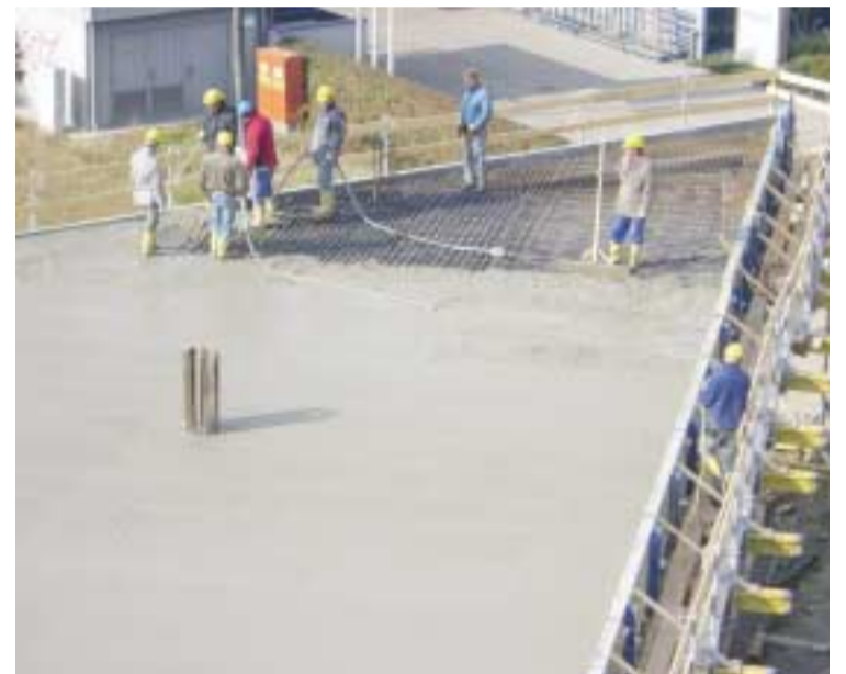
Die Geschößdecken des Cobico-Gebäudes in Perchtoldsdorf ist mit Cobiax-Kugeln ( Durchmesser 36 Zentimeter) ausgeführt. Versorgungsleitungen für Strom, Wasser und Kanal sowie die Lüftungsrohre wurden in die Decken integriert. Fotos: Cobiax
