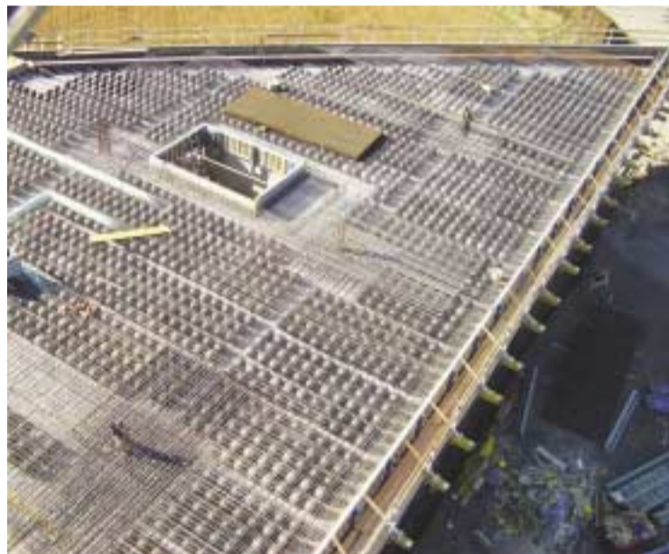
Die Geschößdecken des Cobico-Gebäudes in Perchtoldsdorf ist mit Cobiax-Kugeln ( Durchmesser 36 Zentimeter) ausgeführt. Versorgungsleitungen für Strom, Wasser und Kanal sowie die Lüftungsrohre wurden in die Decken integriert. Fotos: Cobiax
