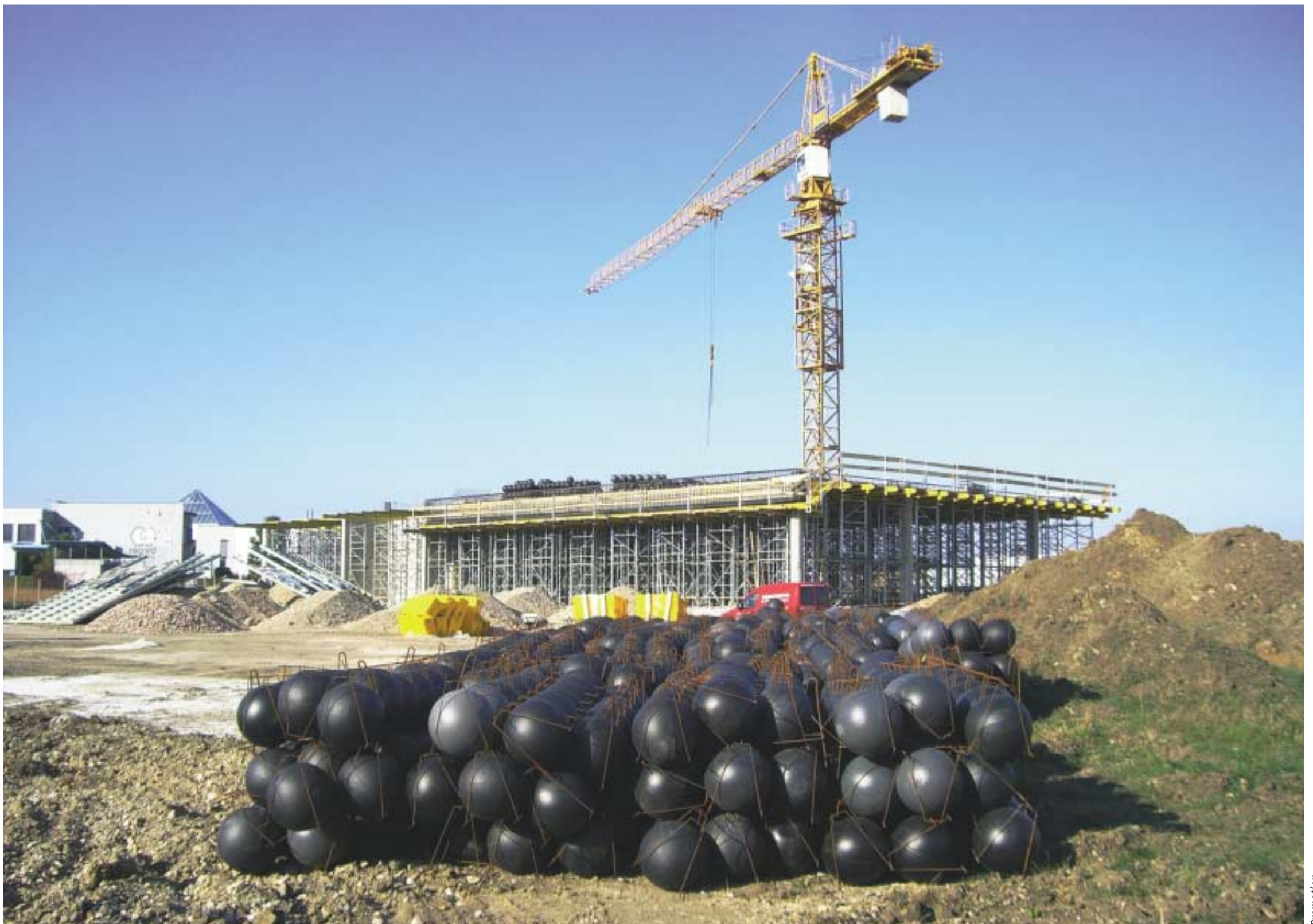
Die Geschößdecken des Cobico-Gebäudes in Perchtoldsdorf ist mit Cobiax-Kugeln ( Durchmesser 36 Zentimeter) ausgeführt. Versorgungsleitungen für Strom, Wasser und Kanal sowie die Lüftungsrohre wurden in die Decken integriert. Fotos: Cobiax
