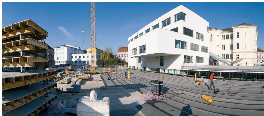
BRG Freistadt, Oberösterreich: Im Zuge der Gebäudesanierung erfolgt auch der Neubau einer Sportstätte mit darunter liegender Garage.
