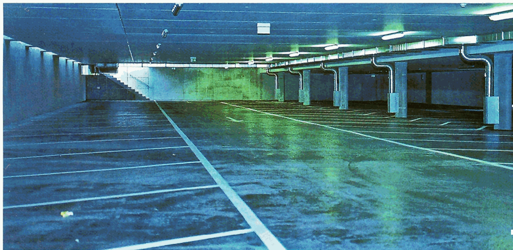
Kundenfreundliches Parkhaus mit nur einer Stützenreihe, die den Verkehr nicht behindert. (Foto: zvg)
