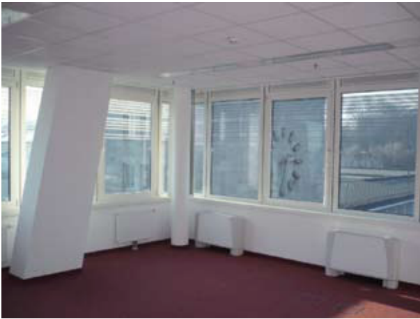
Büro mit Schrägstützen
