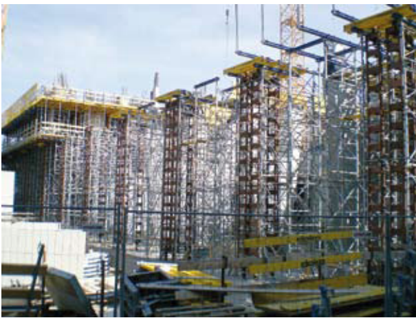
8 m hohe Schalungstürme
