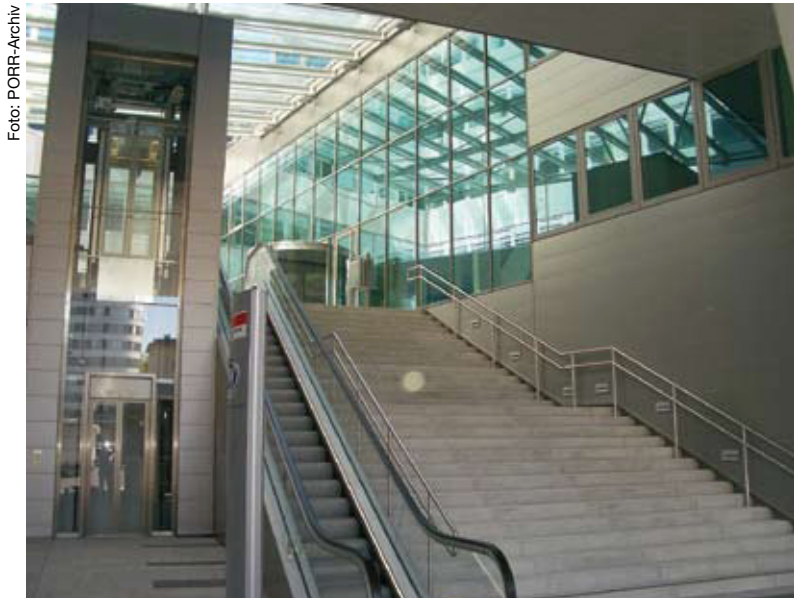
Panoramalift und Rolltreppe
