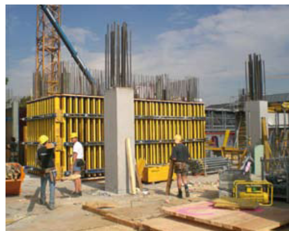
Schalung der Kerne
