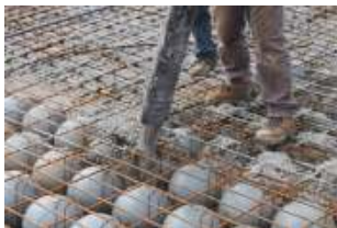
© SM Des corps creux sphériques en matière plastique remplacent le béton là où il n'est pas nécessaire.
