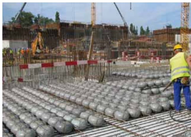
Section typique module de cage Cobiax Slim-Line en combinaison avec prédalle
